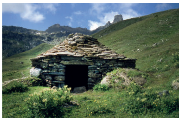
Ancien abri de berger de Comba Econdoi
